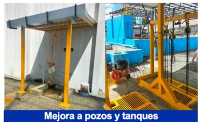
Mejora a pozos y tanques
