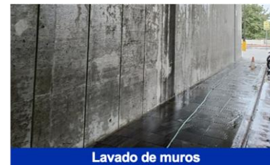
Lavado de muros
