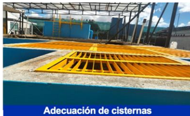
Adecuación de cisternas
