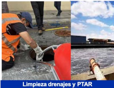
Limpieza drenajes y PTAR
