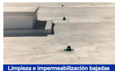
Limpieza e impermeabilización bajadas
