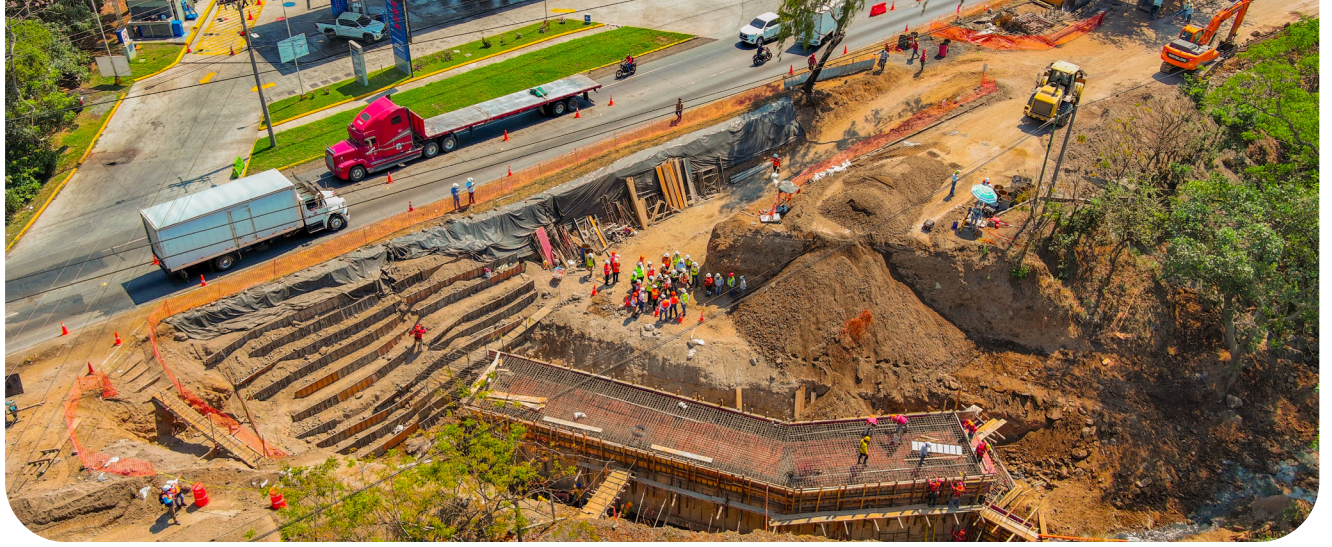
Integrantes del Conadie supervisaron la ampliación de un tercer carril en la autopista Escuintla-Puerto Quetzal.
